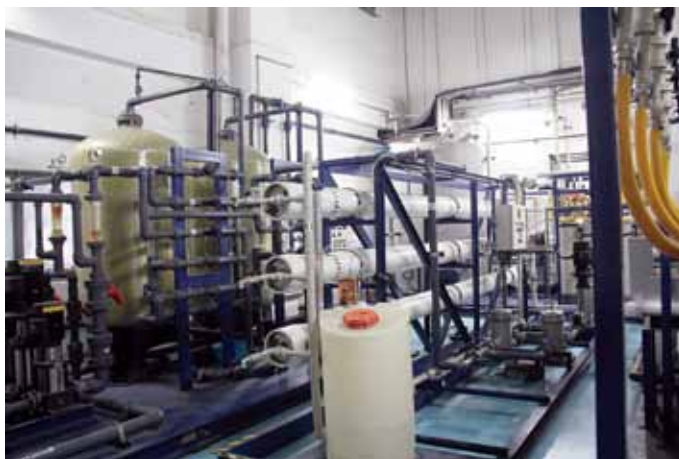
上图为水处理车间
